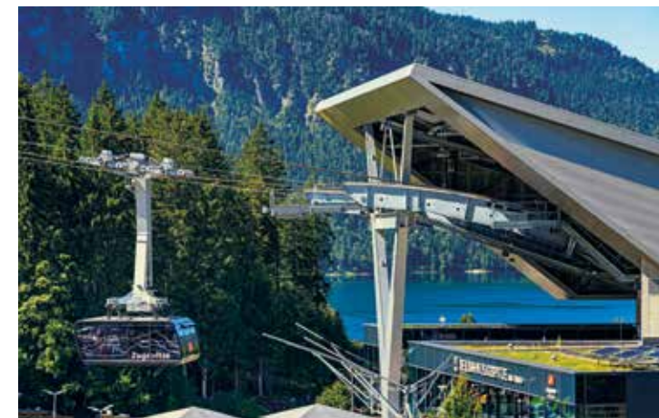
Talstation am Eibsee
